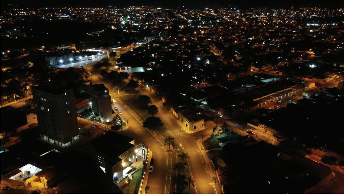
Programa Luzes de Jaboticabal moderniza a iluminação pública: substituição de lâmpadas convencionais por LED já transforma as ruas da cidade, trazendo mais segurança, economia e sustentabilidade.
