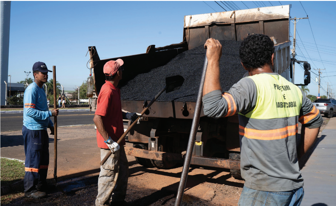
Operação de recapeamento asfáltico. A ação faz parte do cronograma de manutenção viária, garantindo mais segurança, mobilidade e qualidade nas ruas da cidade.
